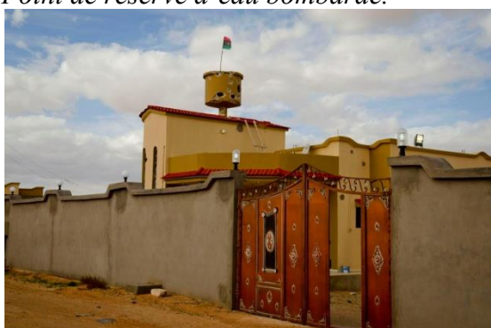
Réserve d'eau bombardée.
